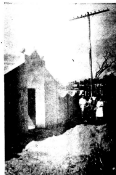
LA NECROPOLIS DE VEGUITAS. —Obras del cementerio que se están realizando en Veguitas (Oriente), bajo la dirección del señor Santiago Ares. (Foto CARTELES)
